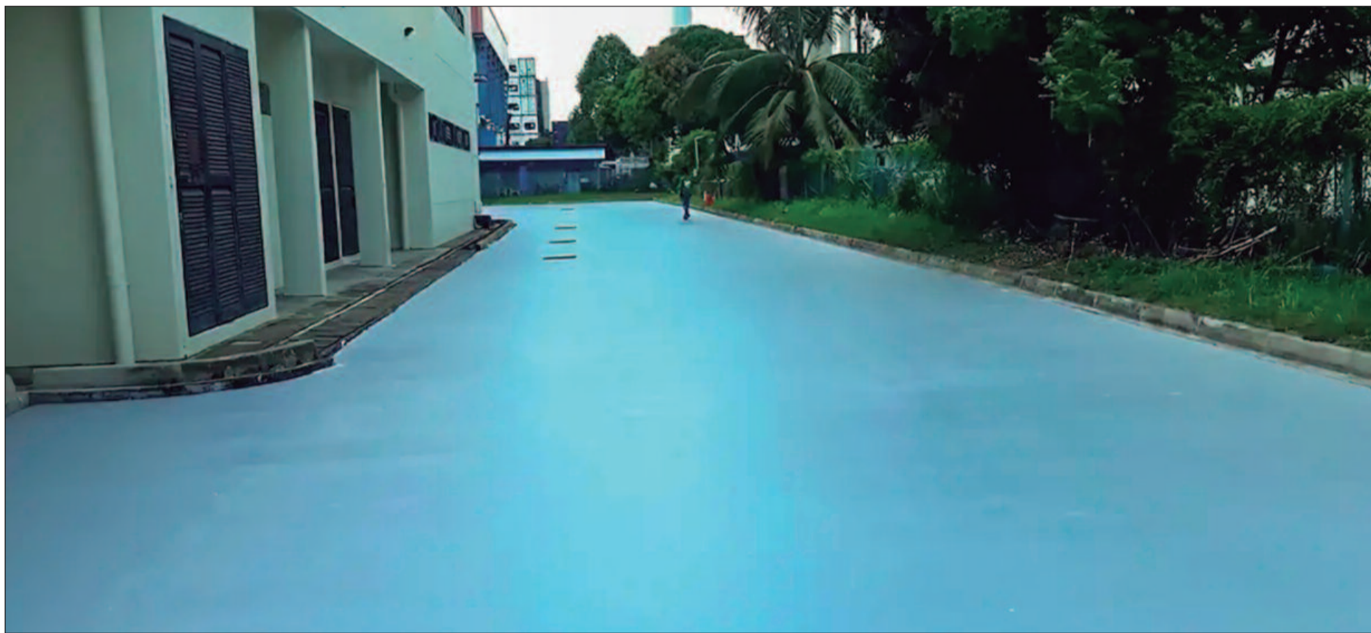
Equipe selecionou quatro edifícios retangulares que criaram dois quarteirões paralelos com ruas estreitas ladeadas por prédios e revestiu os telhados, paredes e pavimentos
