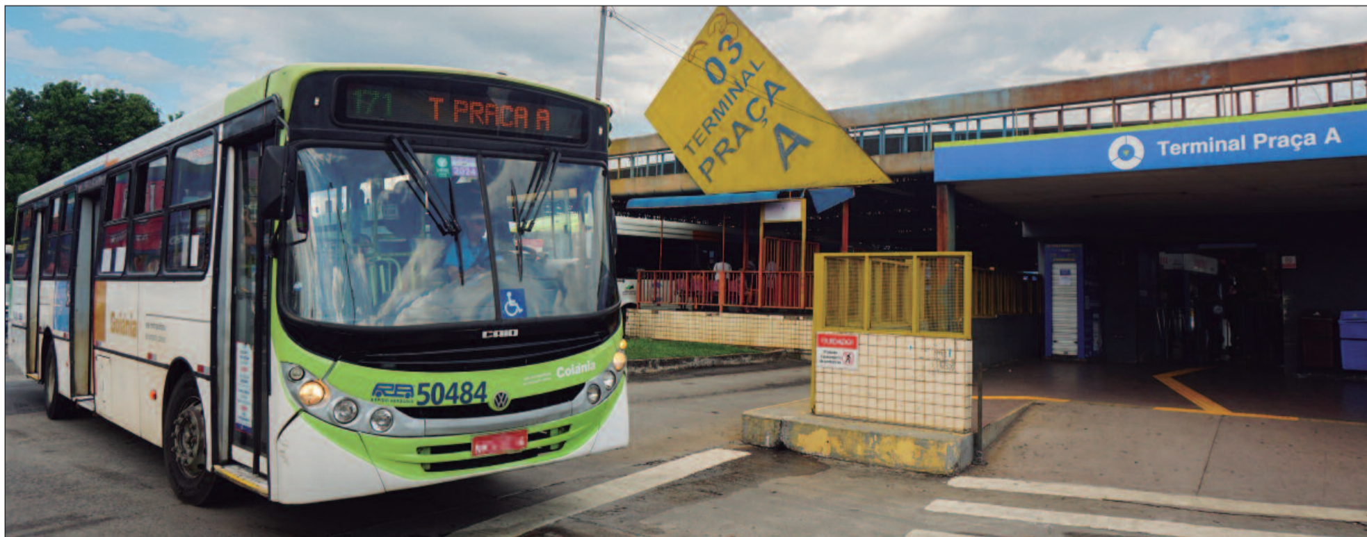
Ônibus saindo do Terminal Praça A: na imagem é perceptível a ferrugem na estrutura do terminal
