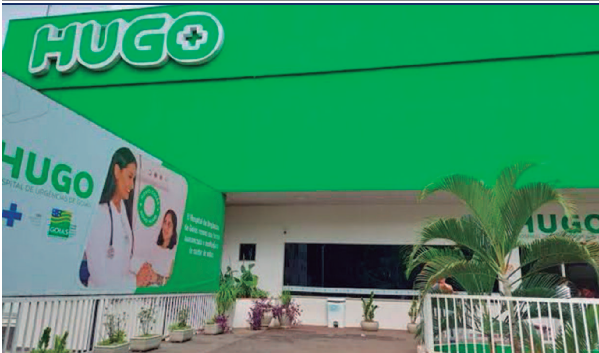
As obras estão previstas para começar em setembro para melhorar a infraestrutura interna e de atenção à saúde
