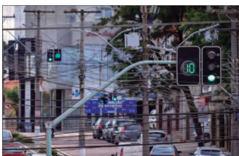
Avenidas T-1, T-63, a T-8 e a T-2 são vias de fluxo intenso que possuem esse mecanismo de semáforos sincronizados
