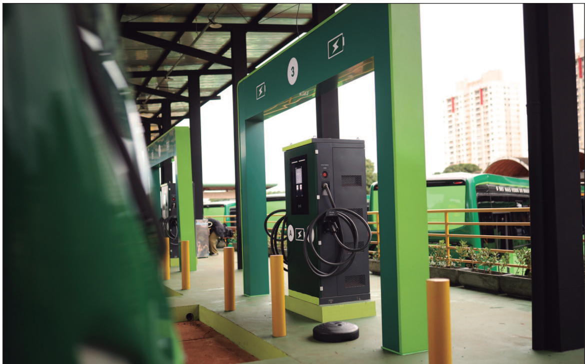
Eletroposto Oeste, considerado o maior do Brasil em potência, garante a recarga simultânea de até 46 ônibus elétricos e assegura a estabilidade da operação da nova frota
