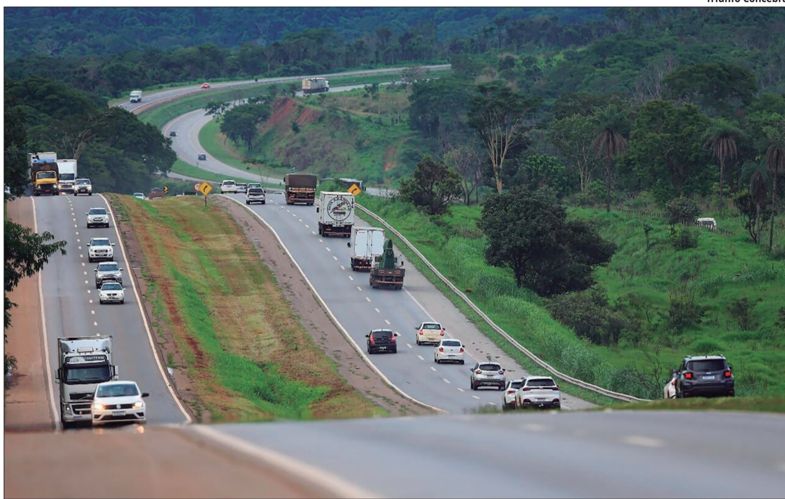
Movimento intenso entre Anápolis e Aliança do Tocantins ocorreu sem vítimas fatais, em meio à ampliação de investimentos
