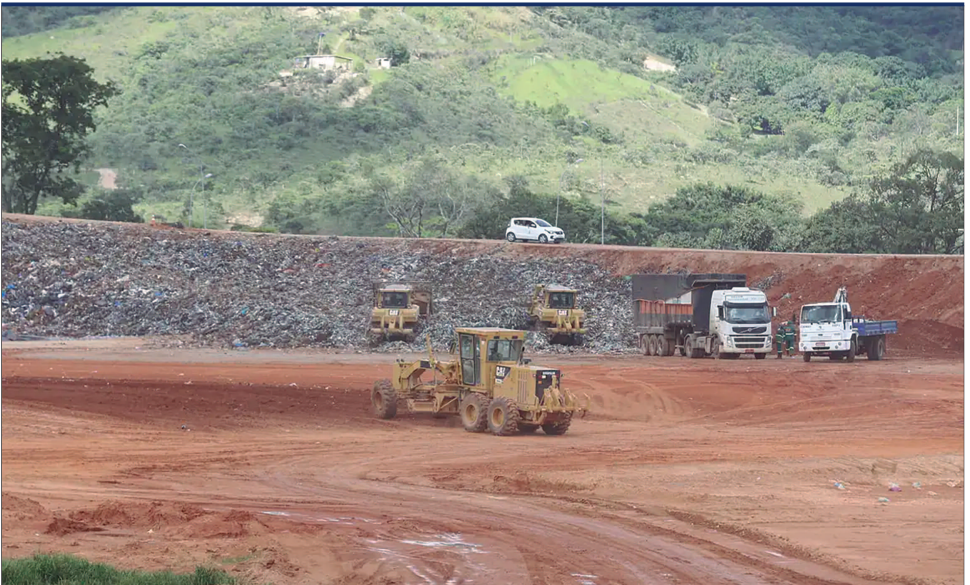
Projeto em Guapó prevê produção de biometano a partir de resíduos orgânicos para abastecimento do transporte coletivo na Grande Goiânia
