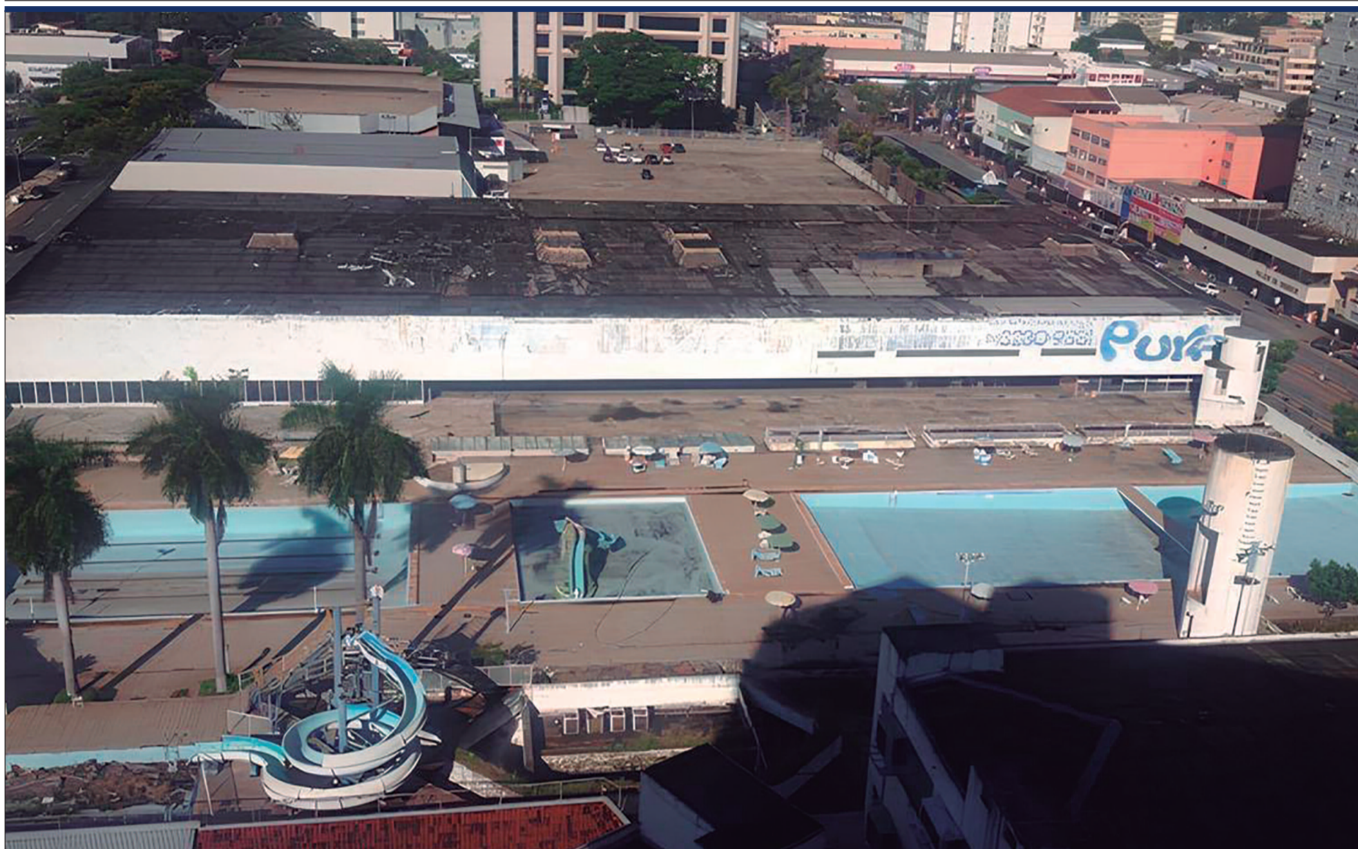
Sem posse do imóvel, prefeitura não avança em projeto de transformação do antigo Jóquei em centro cultural e tecnológico
