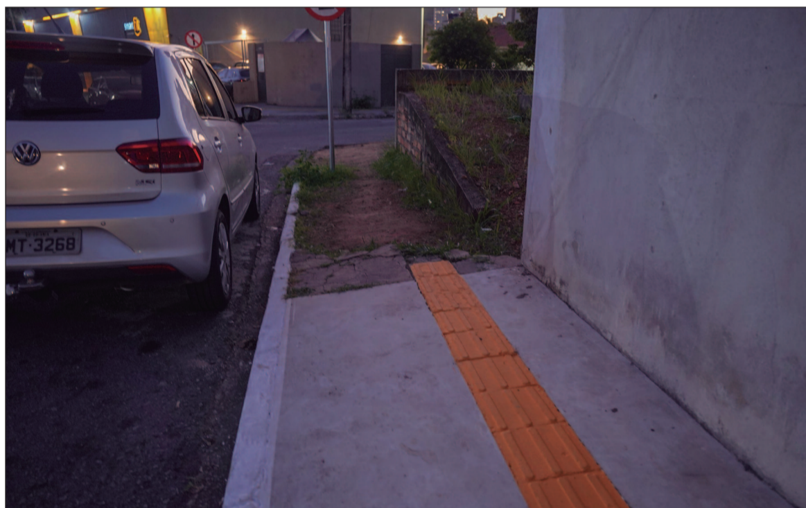
Falhas na instalação, falta de continuidade nas calçadas e ausência de sinalização adequada dificultam a mobilidade
