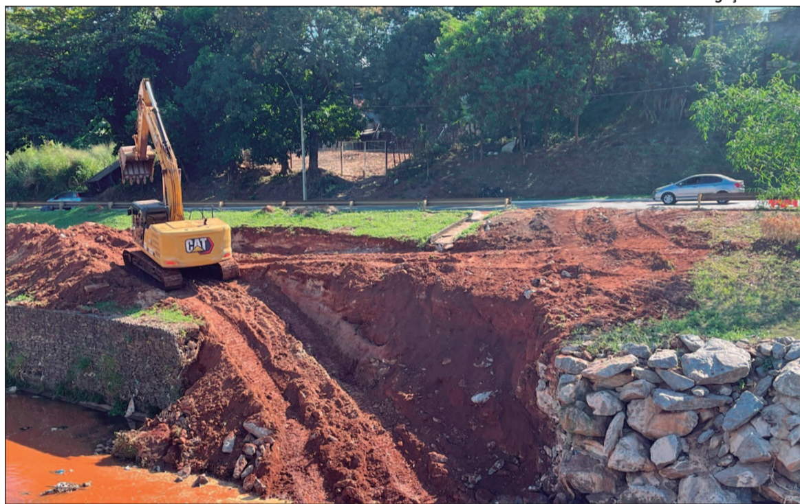
O anúncio da intervenção aconteceu 15 dias após a entrega do Plano Diretor de Drenagem Urbana (PDDU) e já coloca em prática ações previstas no documento
