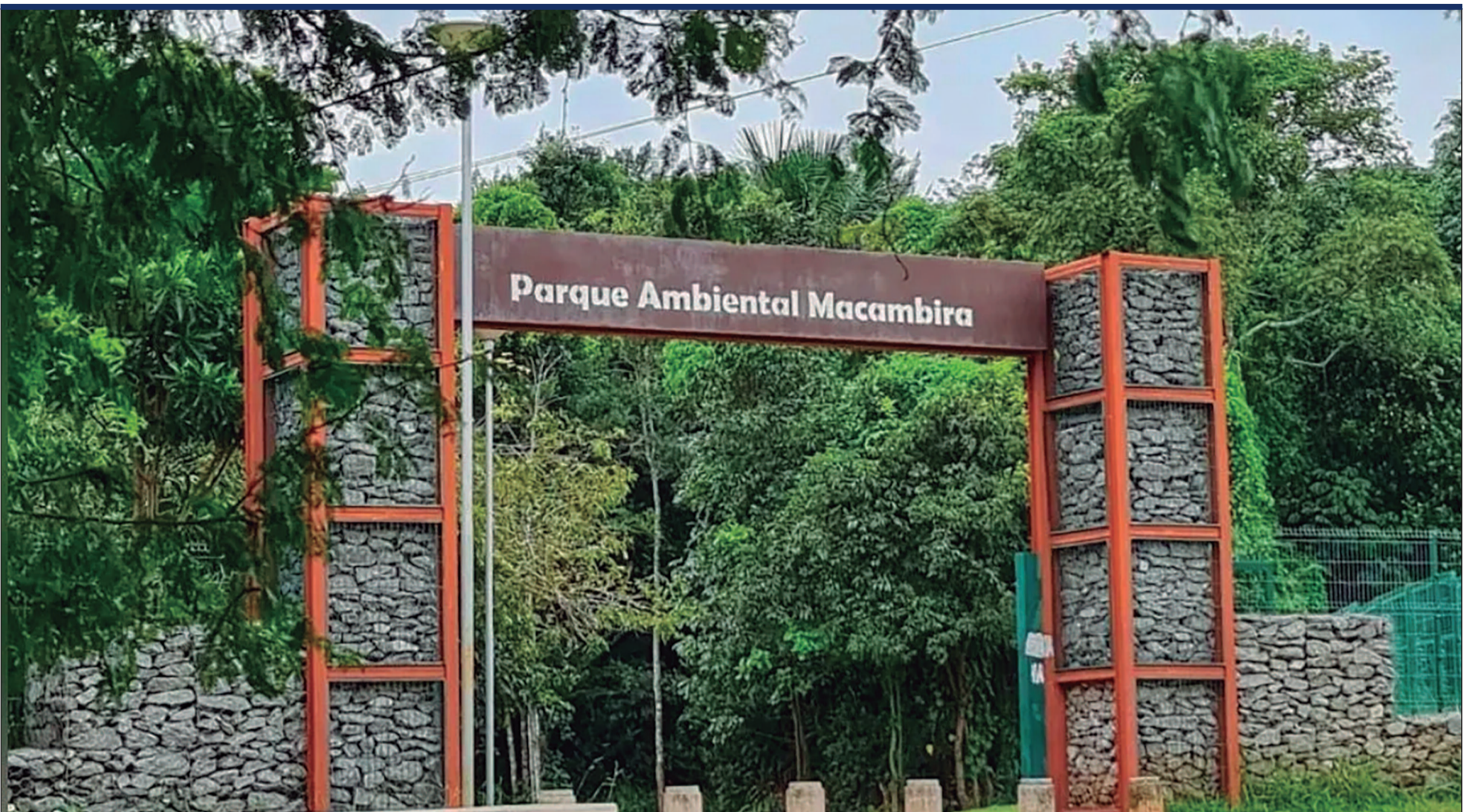
Projeto prevê a ampliação do Parque Macambira Anicuns com intervenções voltadas ao combate de enchentes e à recuperação de áreas degradadas
