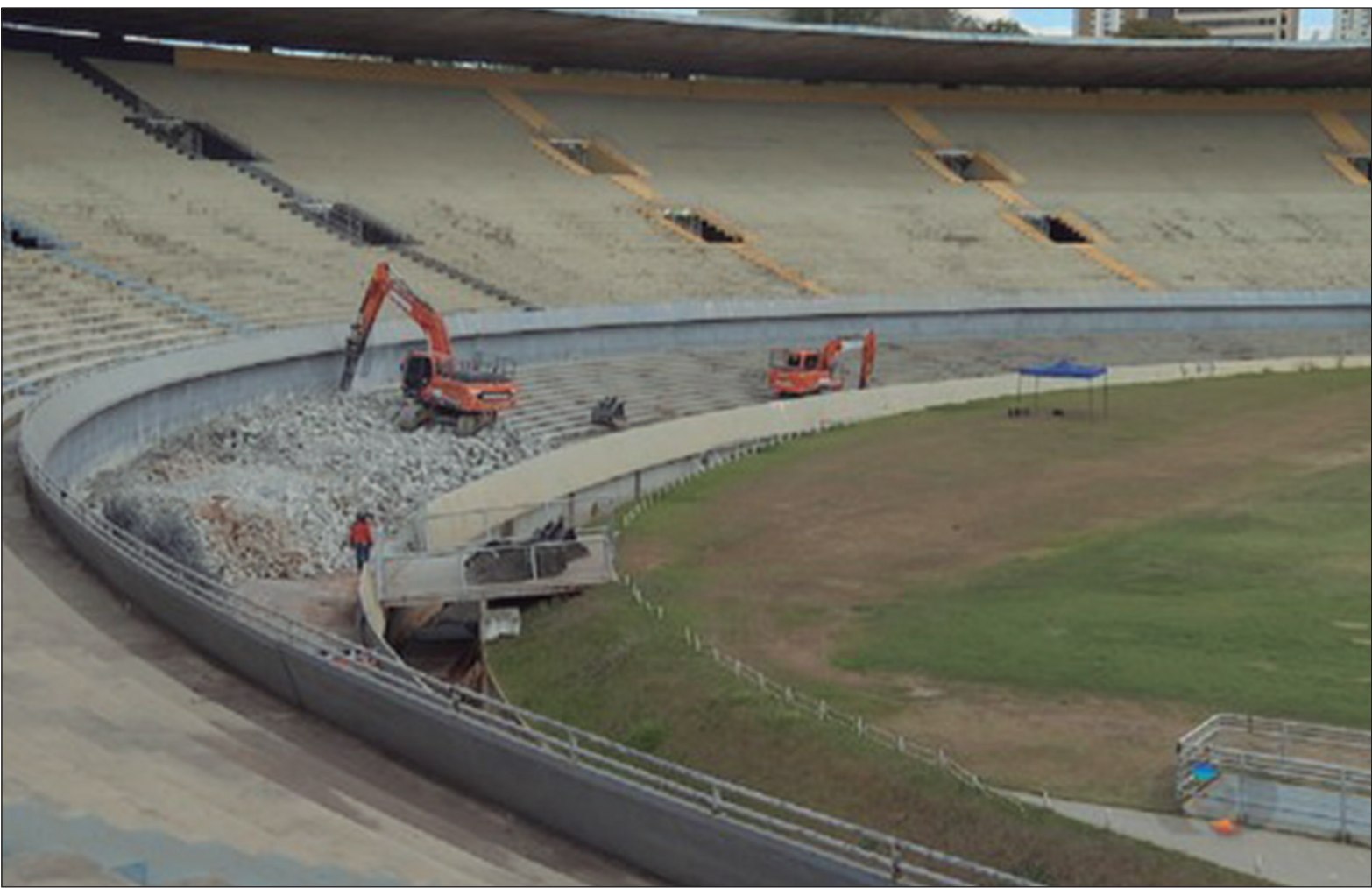
Máquinas já atuam em diferentes frentes de trabalho no Serra Dourada, que passa pela maior reforma de sua história
