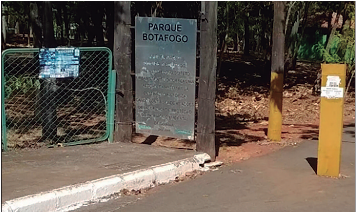
Relatório técnico de 2017 já apontava a ausência de rebaixamento na calçada de acesso
